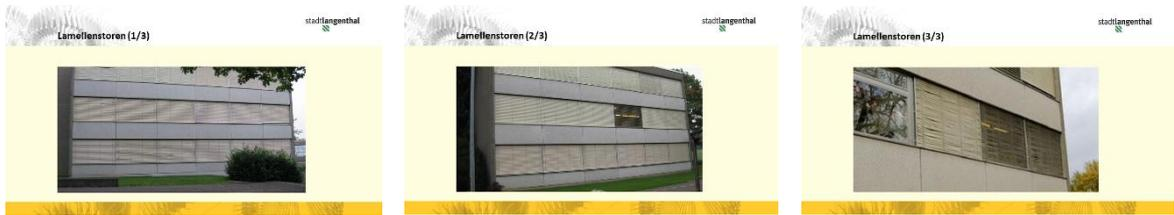
Bei den Lamellenstoren ist ein Gesamtersatz auch unausweichlich, da die Ersatzteile der Einzelstoren nicht mehr lieferbar sind und auch von einem Teilersatz dringend abzurufen ist.
