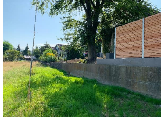
Abbildung 10: Grosser Baum über Schacht 6219
