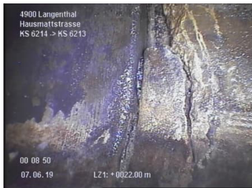
Abbildung 7: Muffe Scherbenbildung
