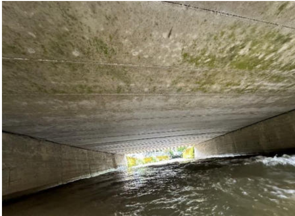
Untersicht Elementträger (Elementbreite 50 cm)
