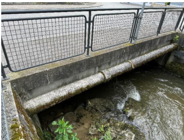
Konsolkopf oberwasserseitig einzelne Risse versintert
