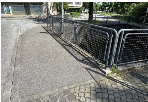
Geländer oberwasserseitig h = 1.0 m ab Ok Konsolkopf
