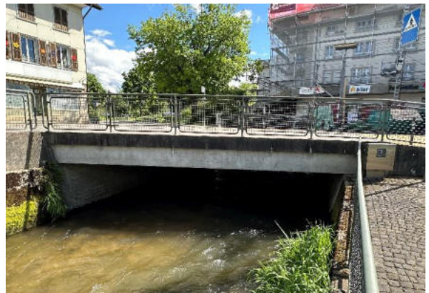
Exponierte Betonoberfläche stark verwittert Konsolkopf unterwasserseitig
