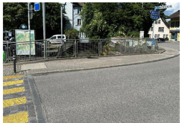
Geländer unterwasserseitig h = 1.0 m ab Ok Konsolkopf
