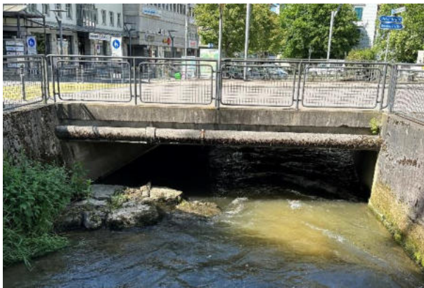
Exponierte Betonoberfläche stark verwittert, einzelne Eckabplatzungen am Konsolkopf, Gasleitung Zementrohr oberwasserseitig stirnseitig an Brückenplatte mit Lasche fixiert.
