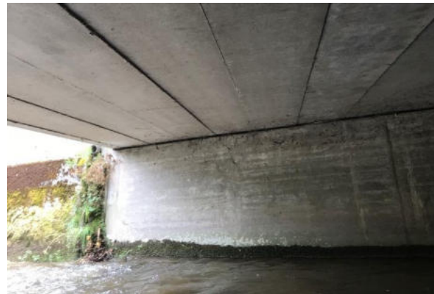
Oberfläche verwaschen, einzelne feine Risse mit Aussinterungen
