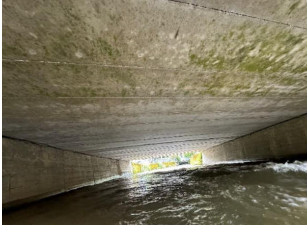
Untersicht Elementträger (Elementbreite 50 cm)
