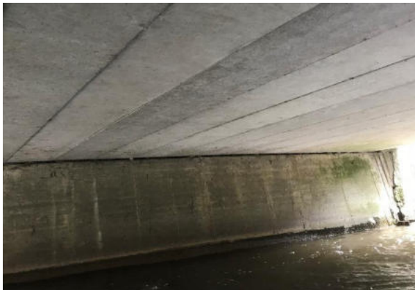
Oberfläche verwaschen, einzelne feine Risse mit Aussinterungen
