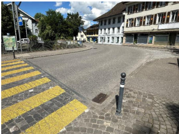
Belag auf Brücke, Einlaufschächte und Plästerung ausserhalb Brückenplatte
