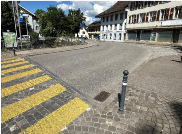
Einlaufschächte beidseitig Fahrbahn, ausserhalb Brückenplatte
