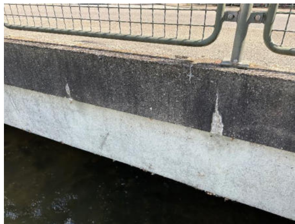
Konsolkopf unterwasserseitig einzelne Risse versintert
