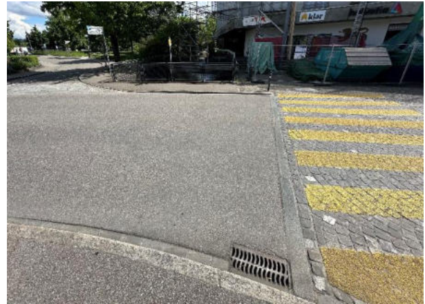
Einlaufschächte beidseitig Fahrbahn, ausserhalb Brückenplatte
