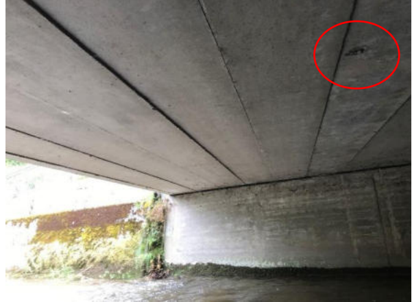
Abplatzung Untersicht Elementträger
