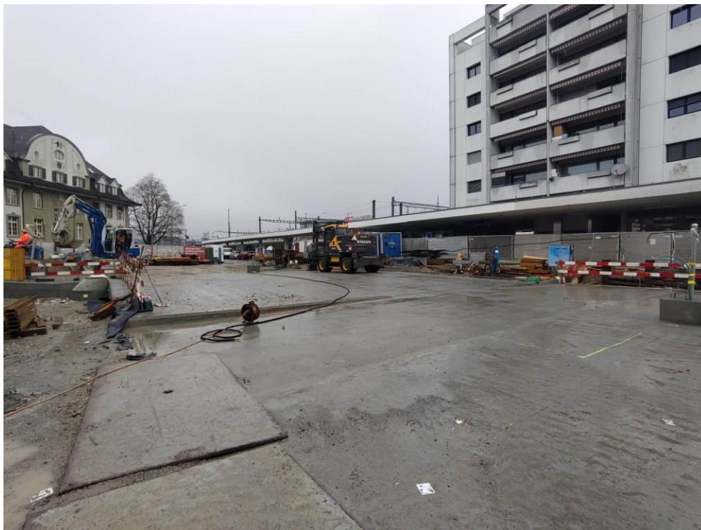
Betondecke HWK und «unterste Lage» für den künftigen Bahnhofplatz Süd
