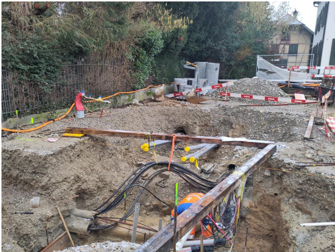
Rohre und Leitungen liegen aufgrund der Bahnhofarbeiten frei und werden teilweise umgelegt sowie je nach Alter ersetzt
