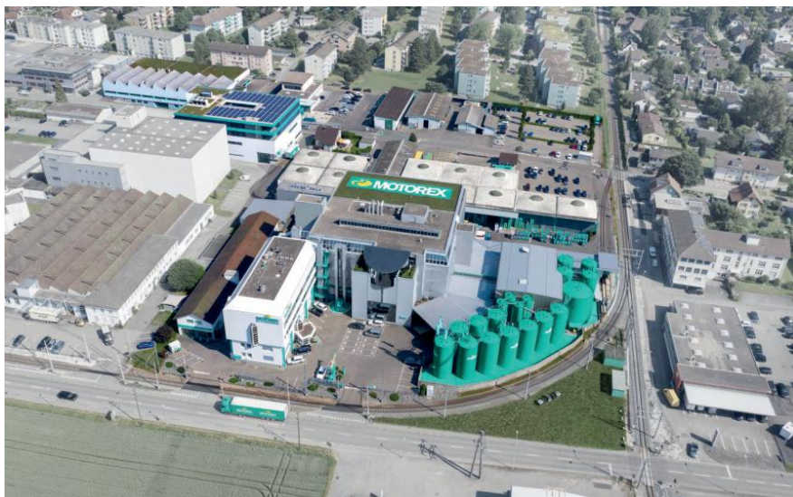
Abbildung 24: Areal der Motorex AG in Langenthal, Blick von Norden; Quelle: Motorex AG
