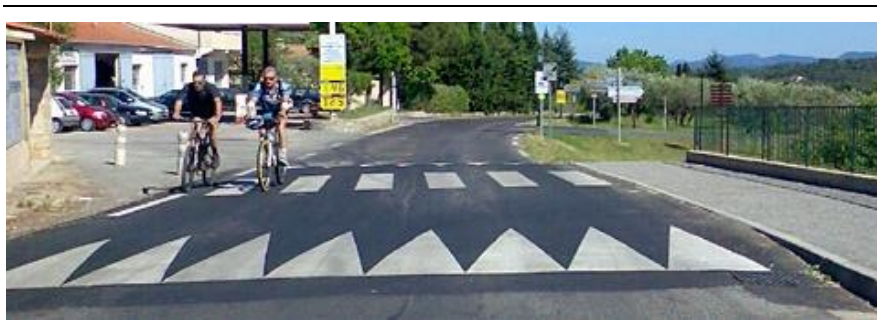
Abbildung 4: Beispiel für Schwelle und Querungshilfe
