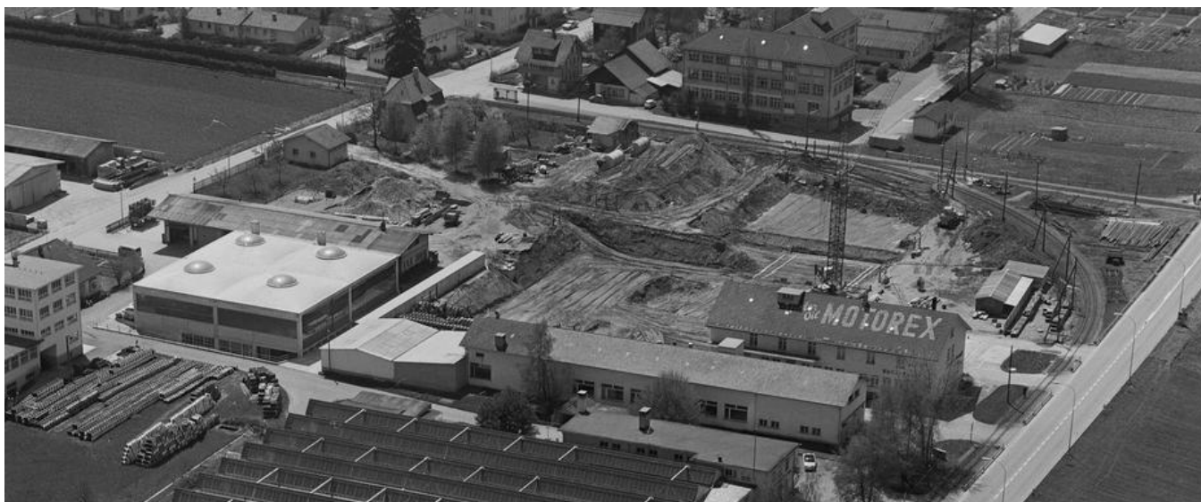
Abbildung 7: Luftbild von 1970 mit der Baugrube und den zwei ersten Motorex Gebäuden [15]
