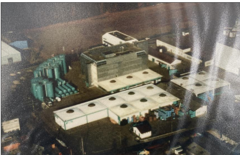
Abbildung 10: Luftbild zwischen 1991 und 1999 mit der Aufstockung des nördlichen Produktionsgebäudes [31]
