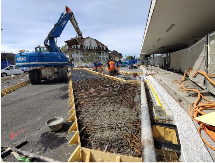
Abbildung 2: Auf dem südlichen Bahnhofplatz entstehen die neuen Bushaltekanten aus Beton.
