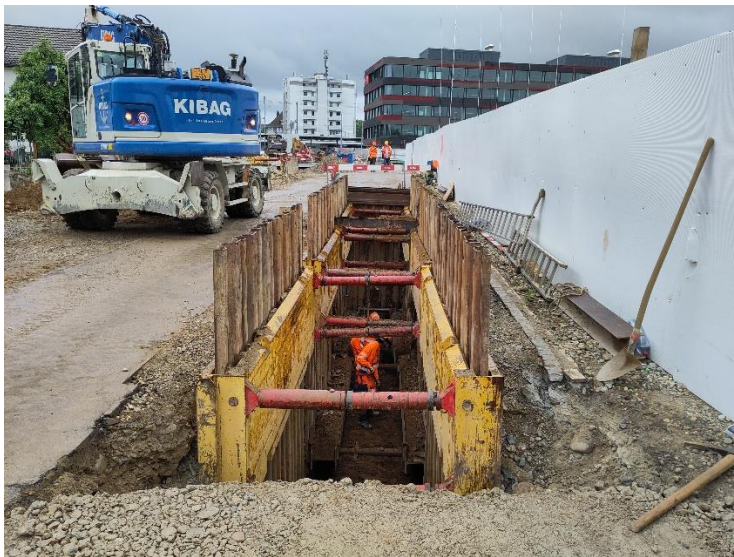
Abbildung 3: Auf der nördlichen Seite des Bahnhofs sind Kanalisationsarbeiten in Gang.
