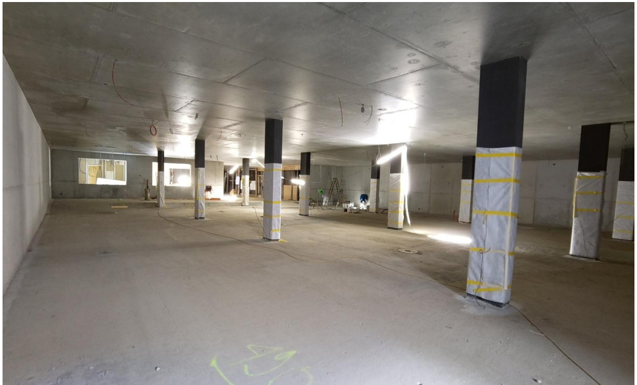
Velostation Süd im Rohbau vor Start Innenausbau
