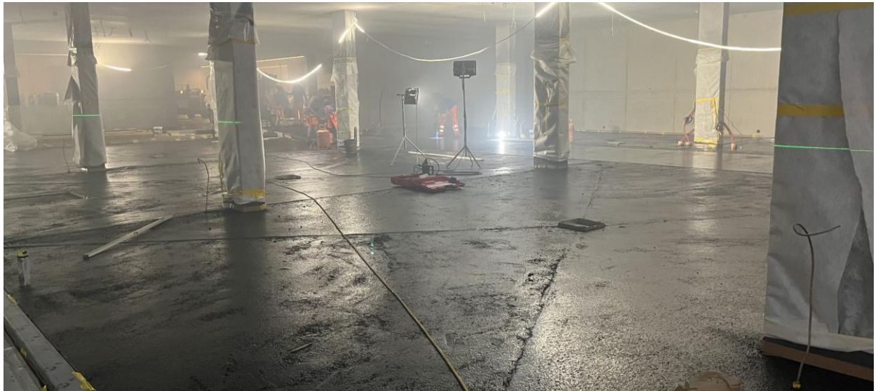
Einbau Gussasphalt Velostation Süd
