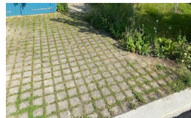
Hauszufahrt mit Sickersteinen
